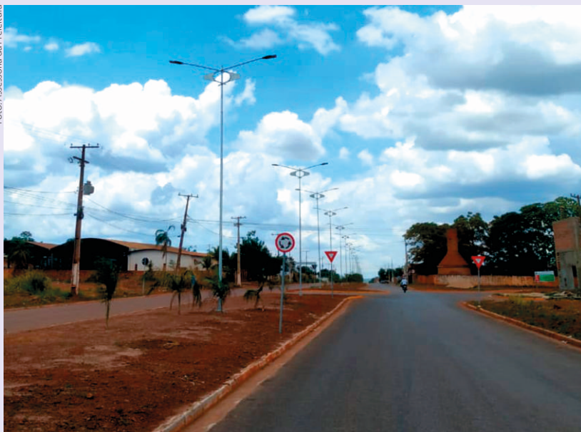
Rede com luminárias de LED foi instalada em uma das principais avenidas da cidade
