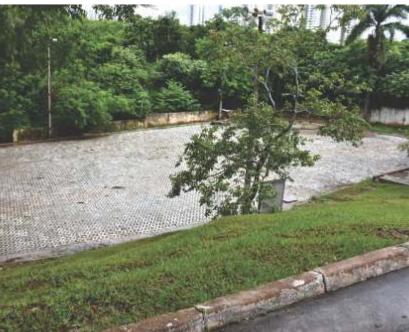
Reforma inclui a ampliação do estacionamento, que contará com 45 novas vagas
