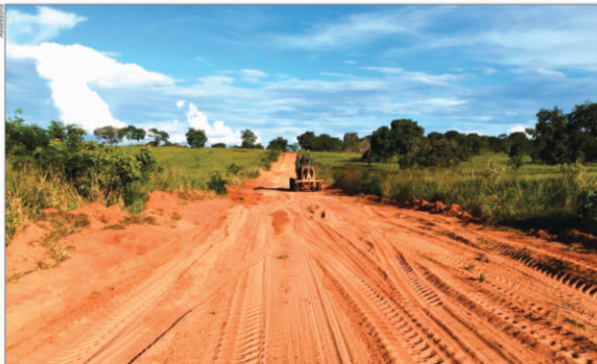
Gestores estão investindo em obras de infraestrutura, como recuperação de estradas
